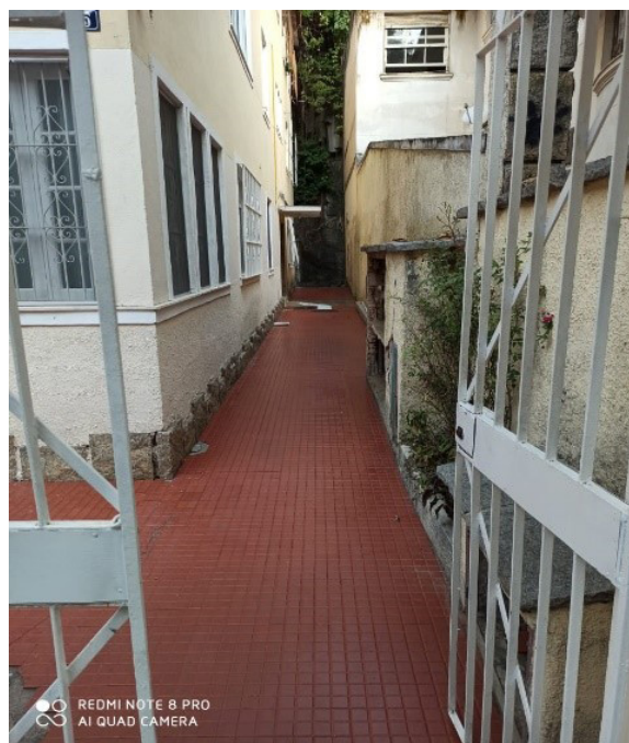
Figura 3: Mesma entrada do prédio em um dia normal, sem deslizamentos, 10 ago. 2023. Fonte: Acervo do autor.
